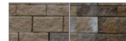
Kerítés hidrofobizált anyagból / Kerítés hidrofobizálás nélkül
