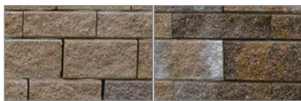
Kerítés hidrofobizált anyagból
