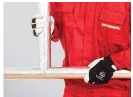
18. kép – Csatlakozó elemek hézagmentes illesztése
