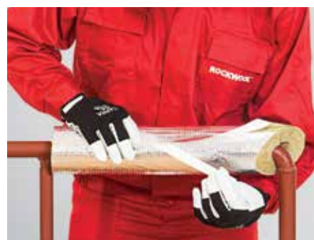
6. kép – A hosszirányú illesztések összeragasztása
