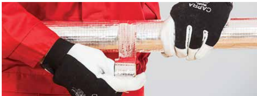
4. kép – Illesztések lezárása alumínium szalaggal
