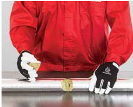
15. kép – 2 \times 45^\circ -os ék kivágása egyenes szakaszon a T elágazás helyén
