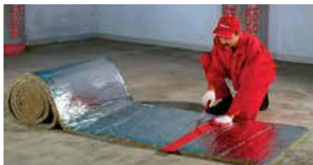
1. lépés – A szigetelés pontos méretre vágása
