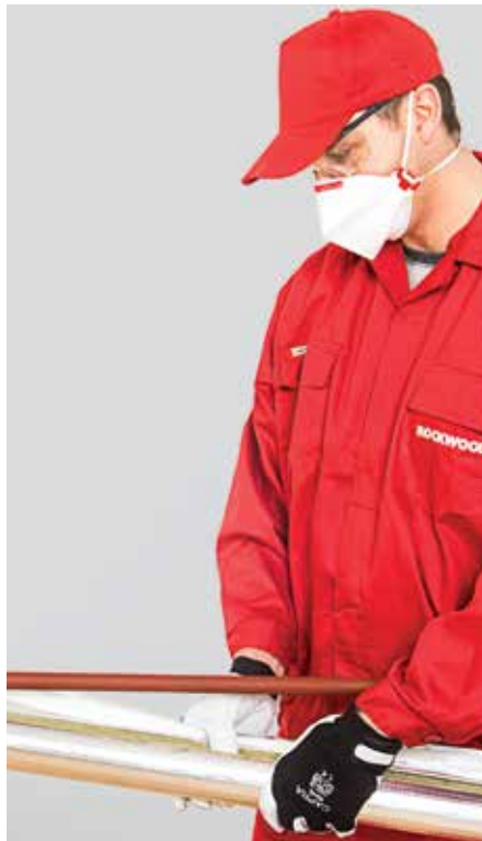
1. kép – A szigetelés felhelyezése
